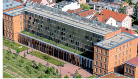
Résidence Junior © TOA architectes
