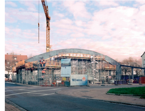
La halle – phase gros-œuvre © Guillaume Porche
