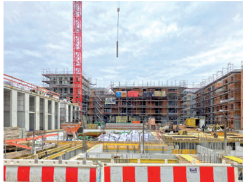
Baustellenfoto © AAg Architekten
