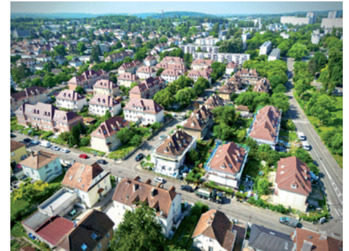
Vue d'ensemble du quartier © drlw architectes
