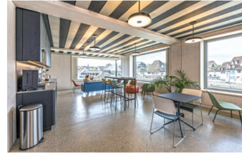
Cafeteria - sichtbare Holz-Beton-Struktur des Gebäudes © Kathrin Schulthess
