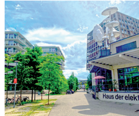
Quartier Dreispitz Campus – plusieurs architectes © Mireille Kuentz
