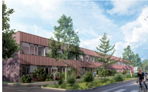
Le nouveau siège de Stabulo France après sa réhabilitation © ballast architectes
