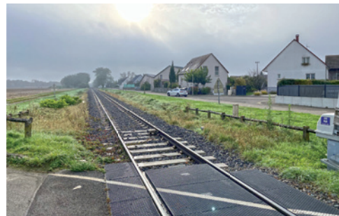
Ligne ferroviaire Colmar–Neuf-Brisach © Dominik Neidlinger
