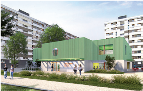
Vue du centre socioculturel rénové © Atelier Buisson architecture
