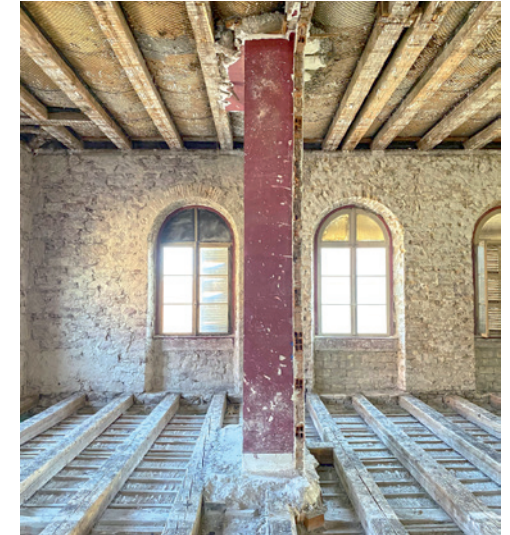
Ancien tribunal de Marckolsheim, chantier en cours © Scherrer & Boetsch Architectes
