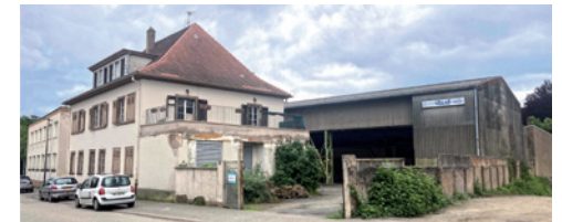
Projet friche Staat © LAMA Architectes
