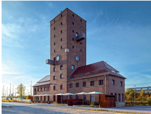
Tankturm Außenansicht © Thilo Ross
