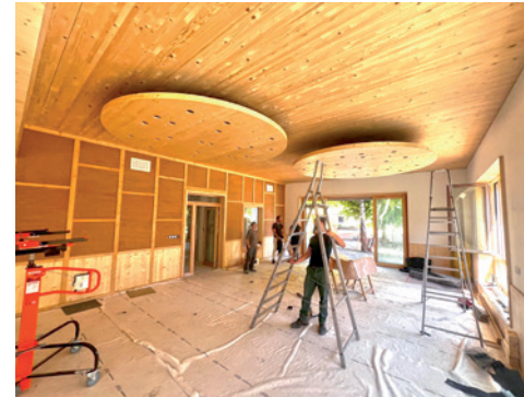
Un chantier bois, à voir achevé! © FUAA Pierre Lynde architecte
