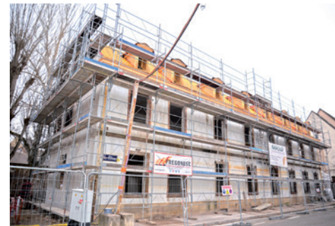
Façade principale de la maison de enfance en travaux © EMS-DAP
