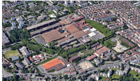
Vue aérienne du site DMC © Google Earth
