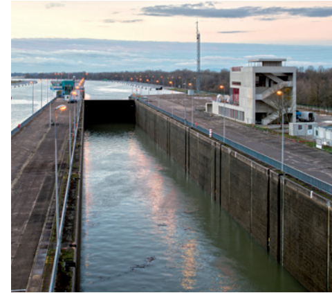
Pôle VNF en cours de chantier © Christophe Bourgeois
