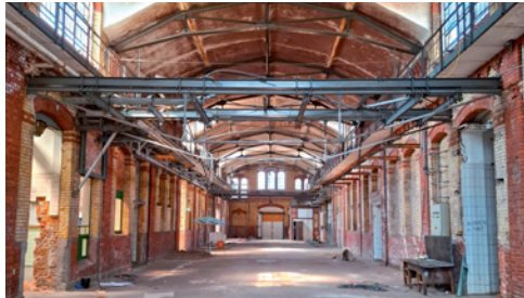
Innenraum Schlachthofgebäude © Link3D/freisign
