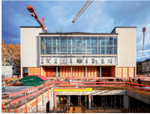
Nationaltheater Mannheim (Architekt: Gerhard Weber) Baustelle © Christian Kleiner
