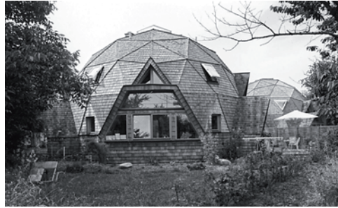
Kuppelhäuser in Mannheim-Neckarau © MARCHIVUM
